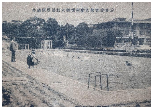
昭和 18 年 2 月-19 年プール完成
